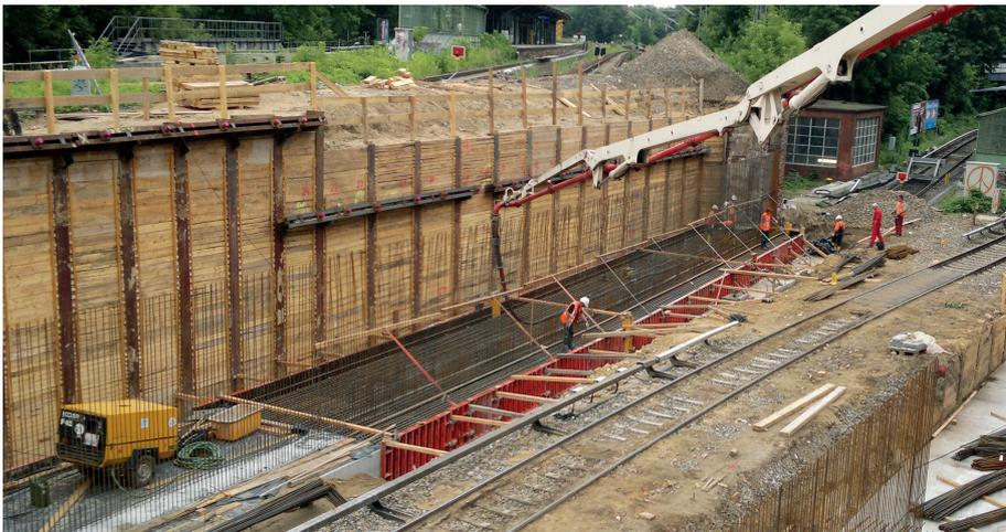
**Abb. 4:** Herstellung der Fundamente für das Kreuzungsbauwerk. Im Hintergrund ist der S-Bahnhof Nikolassee zu erkennen (hier der Bahnsteig der S7)
