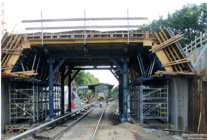
**Abb. 7:** Durch die Baustelle des Kreuzungsbauwerkes wurde ein Rangiergleis gelegt, das täglich für einige Stunden befahrbar gehalten werden musste. Mit Hilfe des (hier in blau zu erkennenden) Schalwagens gelang es, das Lichtraumprofil der S-Bahn freizuhalten.
