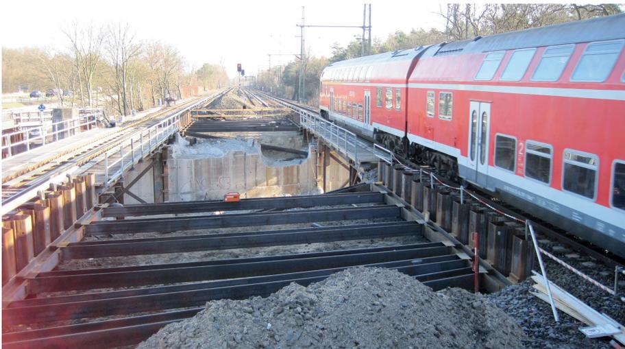
**Abb. 6:** In vielen Bauabschnitten musste in Insellage zwischen befahrenen Gleisen gearbeitet werden – hier am Beispiel EÜ Hüttenweg gut zu erkennen.
